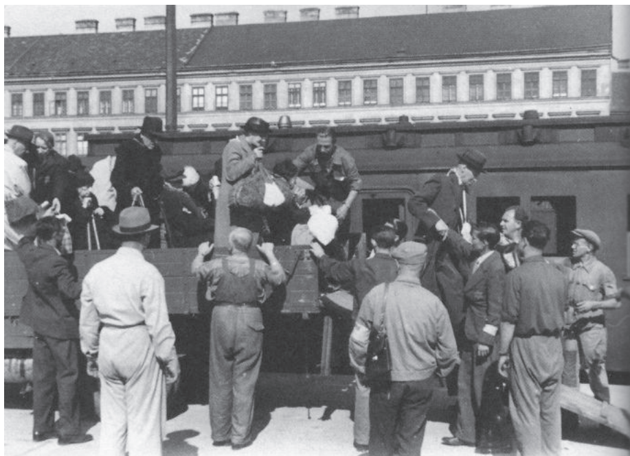
„Judenverschickung in Wien 1942“ (Beschriftung auf der Rückseite), aufgenommen von einem Fotografen namens Reich. Es ist das einzig bekannte fotografische Dokument einer Deportation aus Wien. Anhand der Häuser im Hintergrund ist der Aspangbahnhof lokalisierbar.
